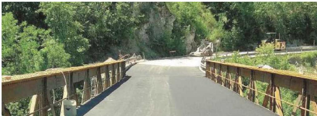
**Rinnovato** Il ponte è costituito da due archi e una campata centrale in acciaio: è lungo 44 metri.
